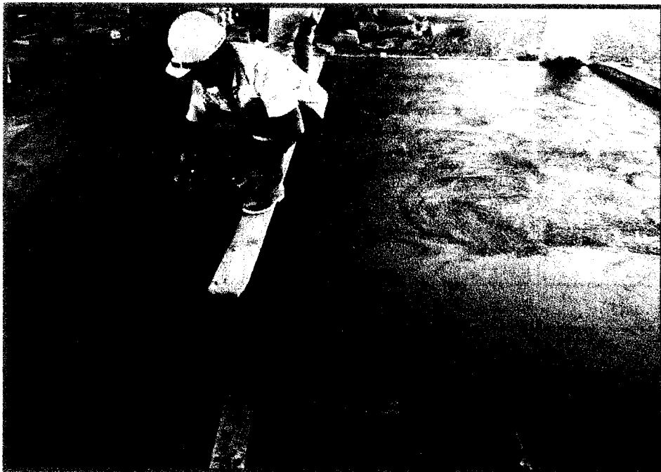
Trabajos de pulido en paño
