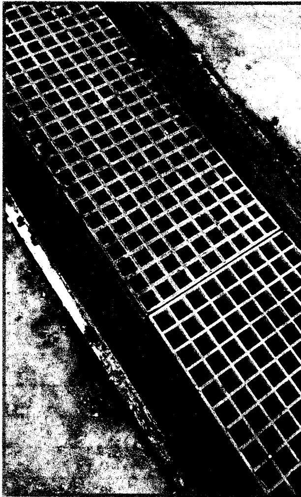
Reposición de canaletas
