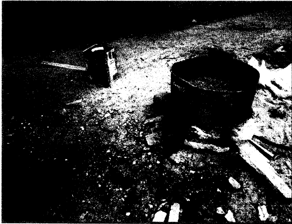
Preparación de Asfalto líquido con arena cernida para junta de dilatación
